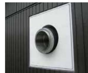
壁面にめがね石を納め、外壁に沿って屋根の上まで断熱煙突が立ち上がり、煙突が建物のアクセントとなるタイプです。
